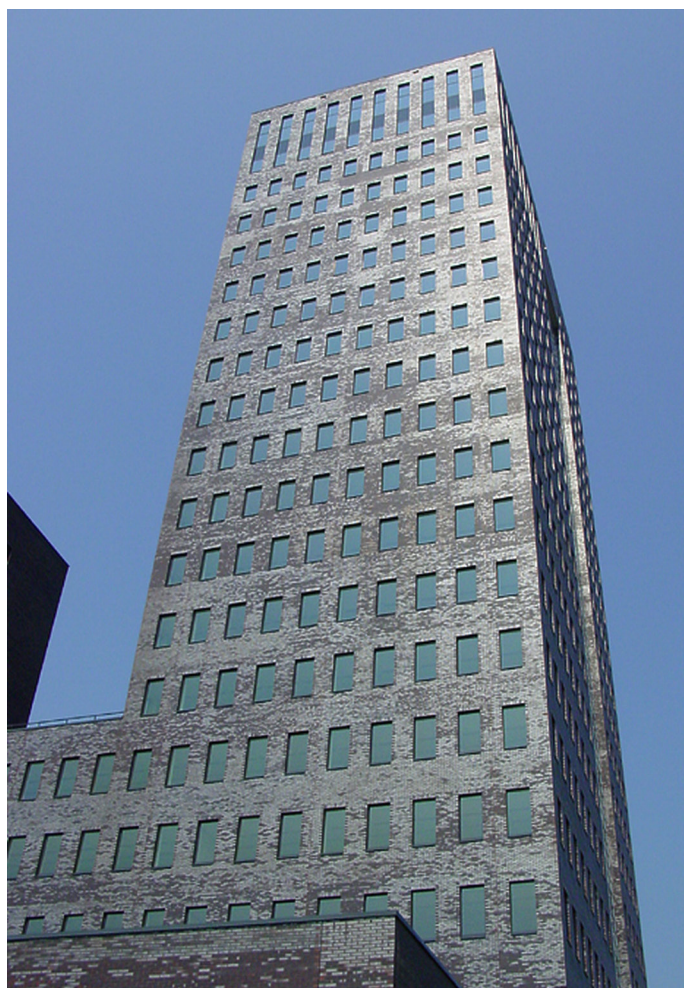
Polder Capital BV | Tower 19 - 16e verdieping - Almere
